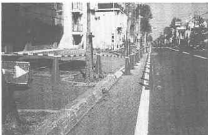
写真－3 歩道工事個所で見られる例
