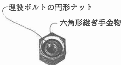
写真-2 六角形継ぎ手金物内空部の円形ナットとの関係
