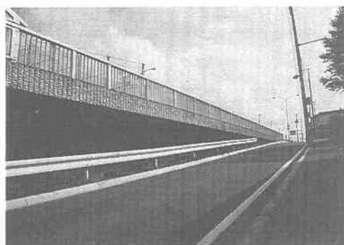
写真一八 化粧型枠（深目地）
