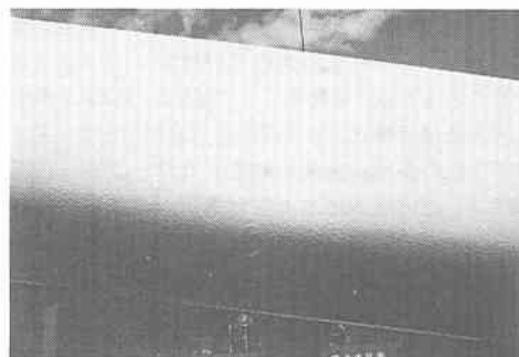
写真-4 ケーブル塗装完了状況
