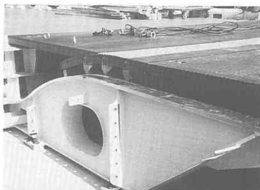
写真－1 伸縮装置設置状況（側塔部）
