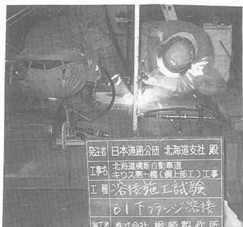
写真-1 下フランジのアークリレー溶接
