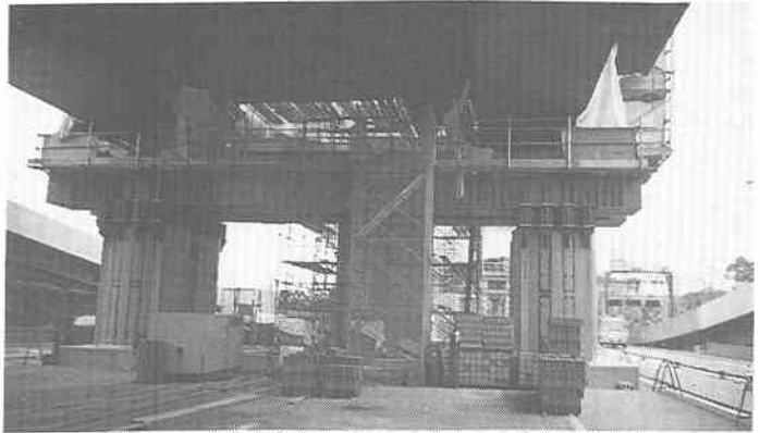
写真-3 大口径桁受けベント
