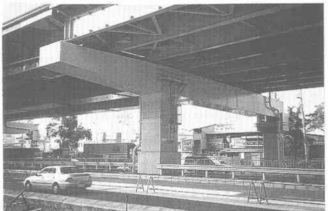
写真-5 P170 橋脚復旧後の状況
