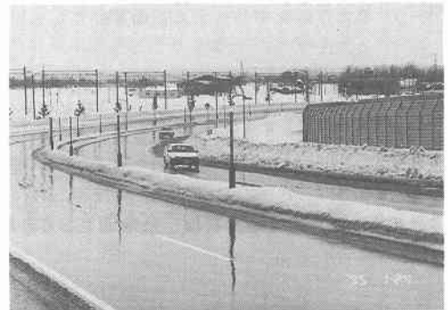
写真-3 一般国道12号江別道路
