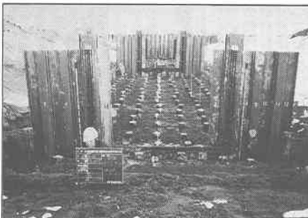
写真-4 可撓矢板設置状況
