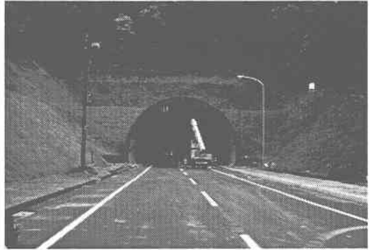
写真一1 施工後の奔茂尻トンネル
