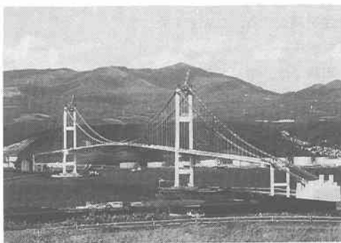
写真-11 架設完了
