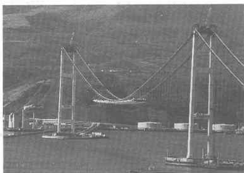
写真-10 30%架設完了
