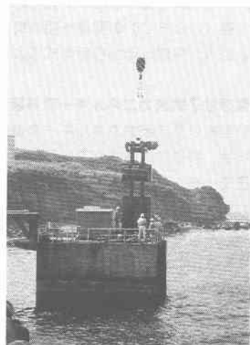
写真-2 据付け作業状況
