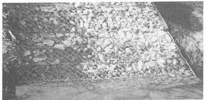
写真-2 廃コンクリート
