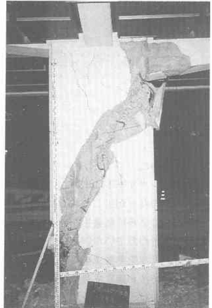
写真-6 鋼橋の橋脚が上流側に約20cm程度傾き道路橋と歩道橋の橋脚の上端部コンクリートが損傷(道路橋:昭和6年建設,歩道橋:昭和47年増設,八戸市売市熊野堂-長苗代内舟渡)
