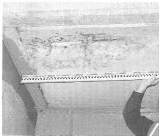
写真-2 桁端部がアハットに衝突し端部のコンクリートが破損剥落しスターラップ等の鉄筋が露出 (合成桁道路橋、別海町風連)
