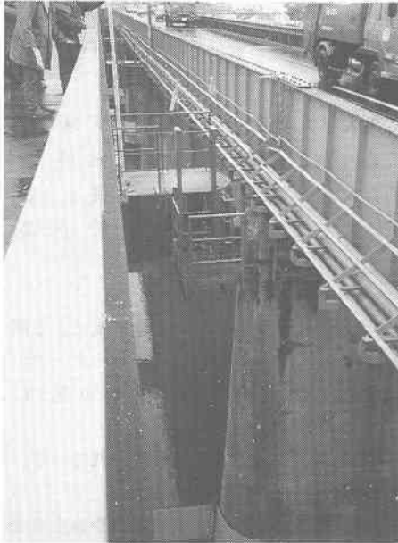
写真-6 鋼橋の橋脚が上流側に約20cm程度傾き道路橋と歩道橋の橋脚の上端部コンクリートが損傷(道路橋:昭和6年建設,歩道橋:昭和47年増設,八戸市売市熊野堂-長苗代内舟渡)
