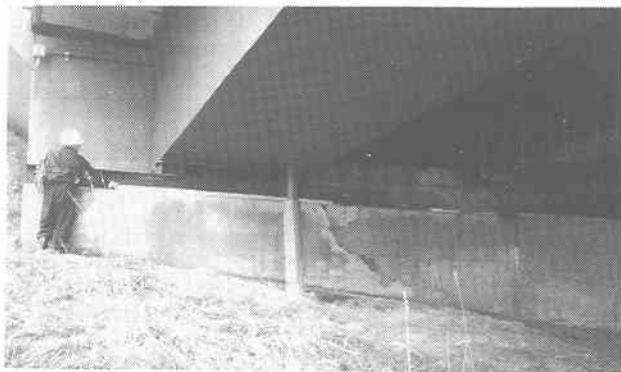
写真-3 沓座のボルトの破断と橋台の支承部コンクリートの上部2m75cm下部4m60cmの幅の亀裂とめくれ上がり(道路橋, 3径間連続, 2主鋼桁ボックス断面橋中標津町緑町)
