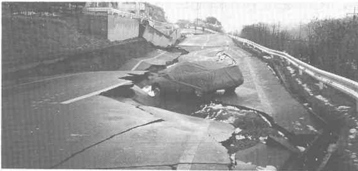
写真-8 道路の盛り土と路盤の崩壊に伴うI字型コンクリート擁壁が3.5m迫り出しと2.5m沈下(八戸市松が丘)
