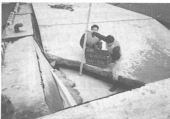
写真-5 防潮堤の基礎付近のコンクリートのひびわれ及び壁にせん断ひびわれ(漁港, 花咲)
