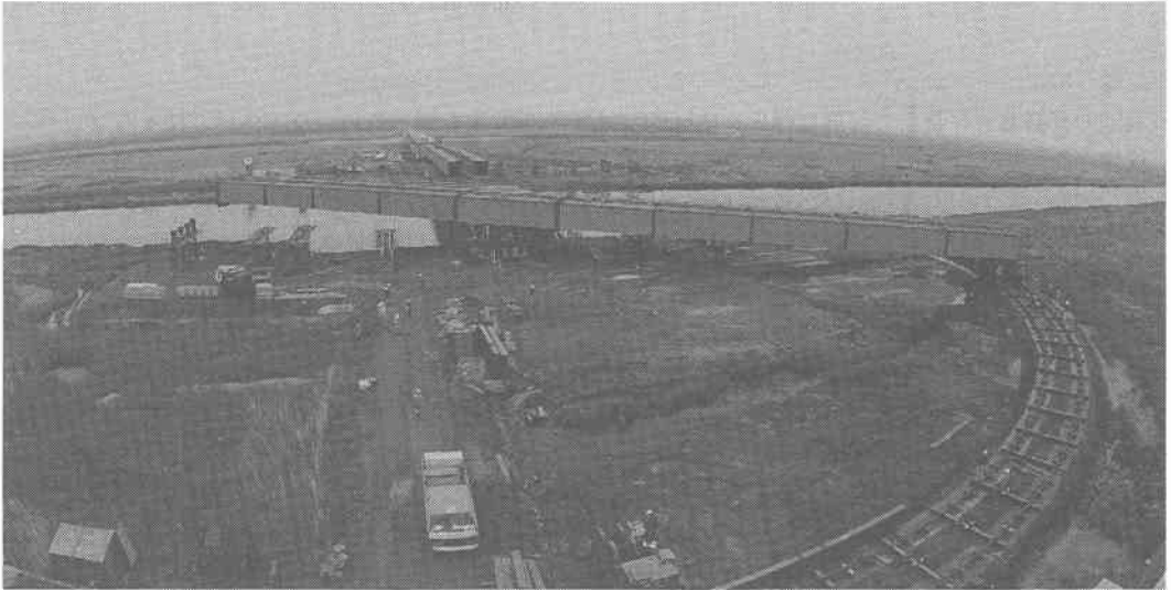
写真－3 回転架設状況
