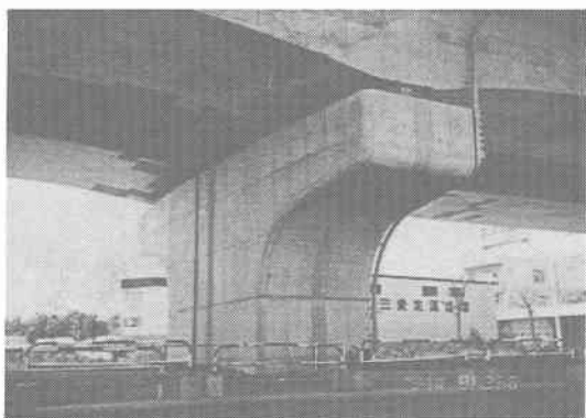
写真-8 札幌新道のコンクリート橋の橋脚(2)
