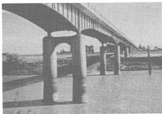
写真-5 清幌橋の河川部
