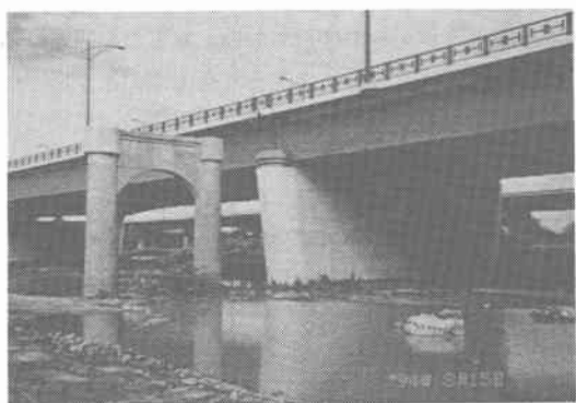
写真-3 江別大橋の新旧の橋脚
