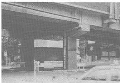
写真-17 東京都内の高架橋
