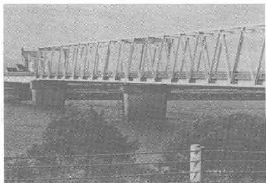
写真-1 石狩大橋
