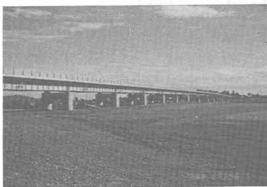
写真-6 清幌橋の河川敷部
