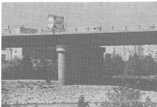
写真-2 南7条大橋
