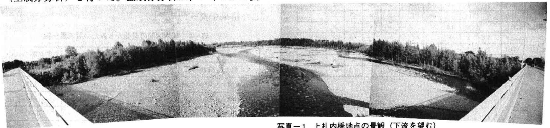
写真-1 上札内橋地点の景観（下流を望む）
