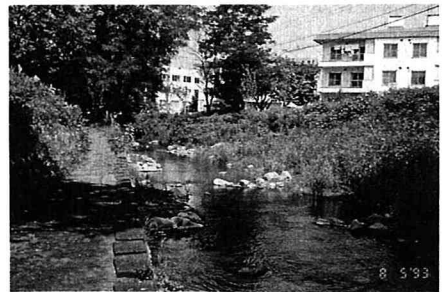
写真-4 緩傾斜護岸
