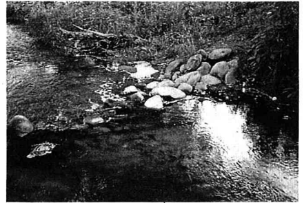
写真-3 玉石帯工
