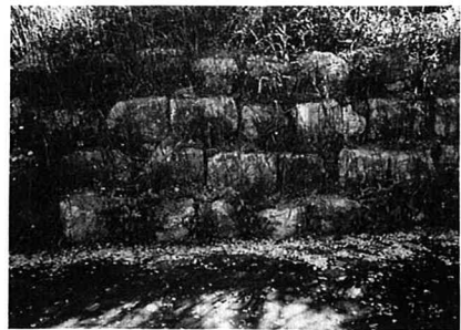
写真-1 コンクリート殻空積護岸
