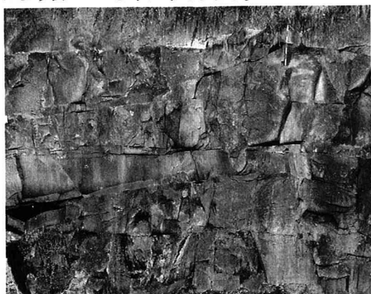
写真-1 原位置岩盤亀裂
