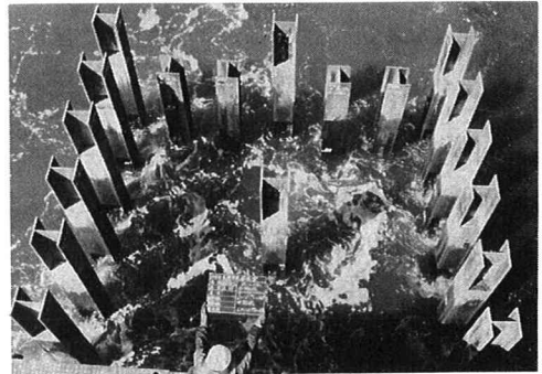
写真-3 1スパン(6m)の杭を打ち終わったところ。
