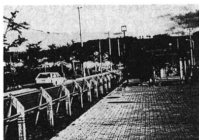
写真7 ガードレール（小町泉通り）
