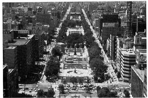
写真-2 リフレッシュ工事が進む大通公園
