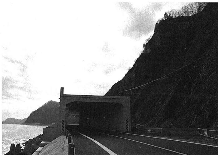
写真-2 美幌覆道
