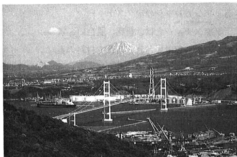
写真-2 合成写真例(測量山展望台より)
