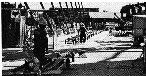
写真-2 短径間斜材のストラッド組立
