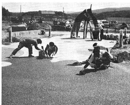
混合物 施工状況写真
