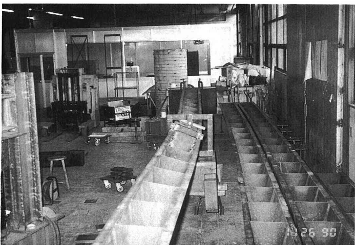
写真-2 全体横倒れ座屈
