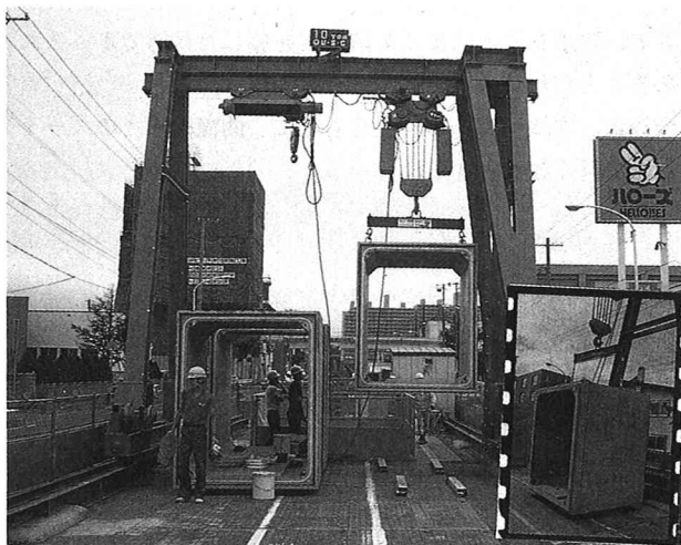
写真-2 ボックスカルバート吊り上げ状況
