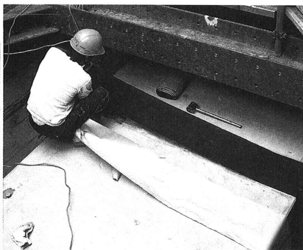
写真-3 立坑内及び防水シート施工状況
