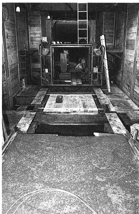
写真-4 立坑内発進用架台設置状況
