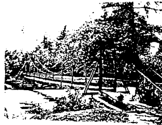
Fig. 6 アラスカの原始吊橋
