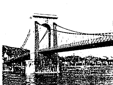
Fig. 14 フランスのローヌ川橋
