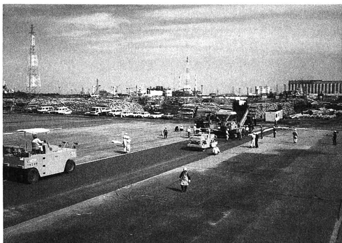
写真 苫小牧木材ヤードのRCCP(1988年6月施工)
