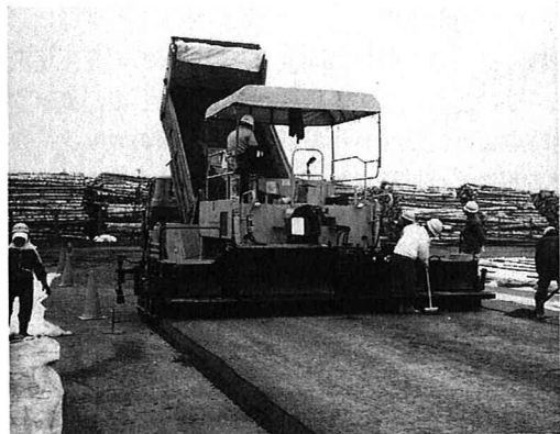
写真-1 施工状況
