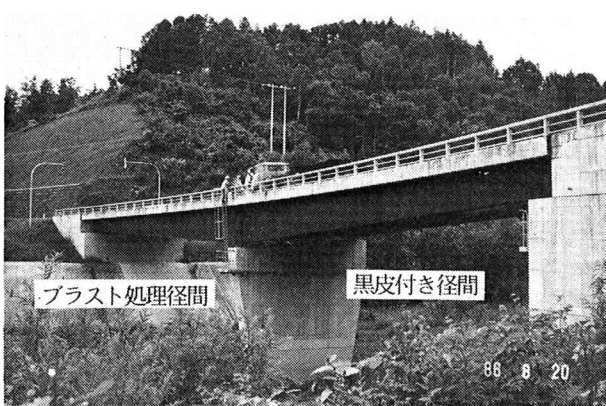
写真－５ 架設後４年経過の外観
