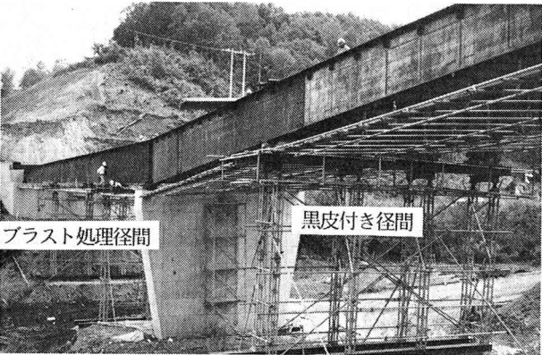
写真－４ 架設時の外観
