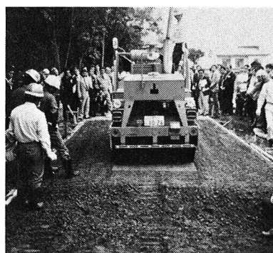
写真-3 R・C・C実用実証公開試験(北海道電力)
