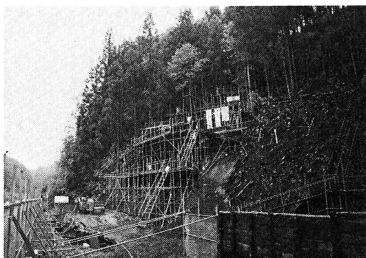
写真-1 トンネル出口斜面での縫地ボルト施工のための鋼管パイプステージ
