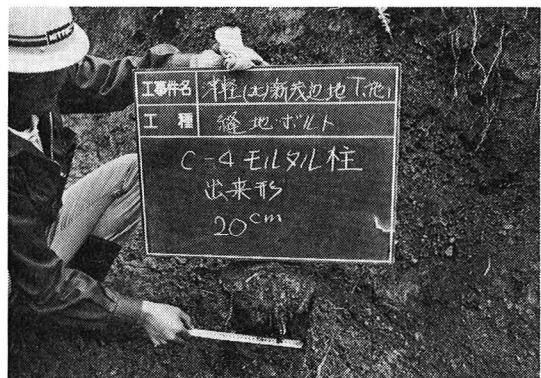
写真-2 縫地ボルト形成状況
