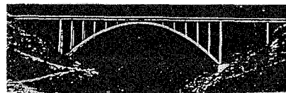
Fig. 19 シンジュ 神樹橋 (鋼逆ローゼ、連続桁、単純合成桁)
