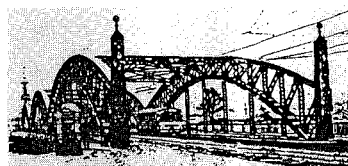
Fig. 6 豊平橋（二代目鋼橋、タイドアーチ）
