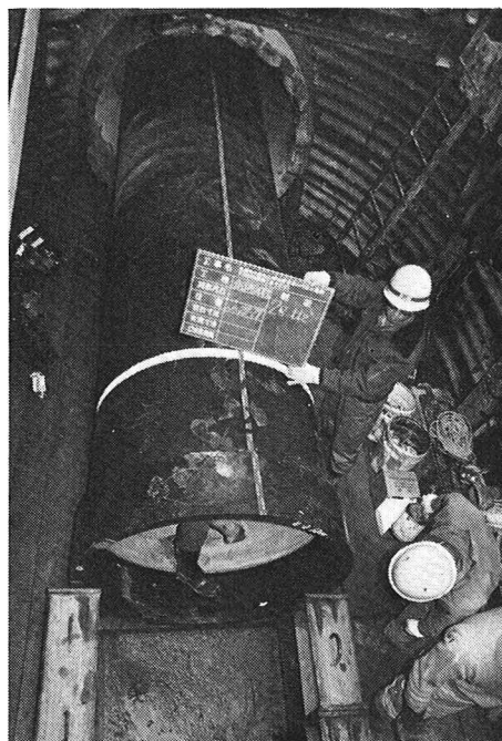
写真-2 川沿幹線布設工事
