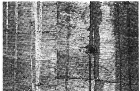
良合板 不良合板
