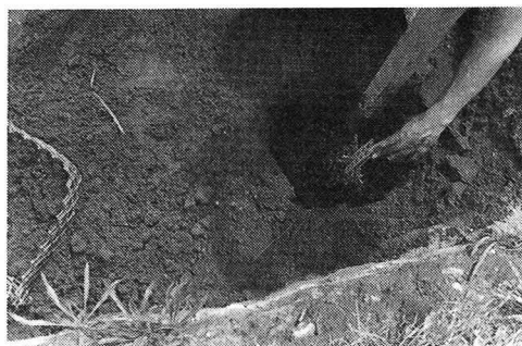
写真3. 埋め込み時の締め固め
