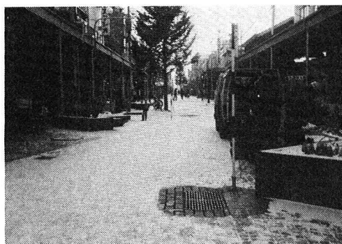
写真-3. 融雪柵設置状況
