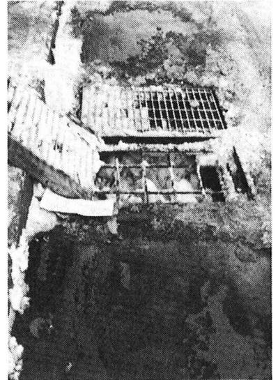
写真-1. 融雪実験中の柵
