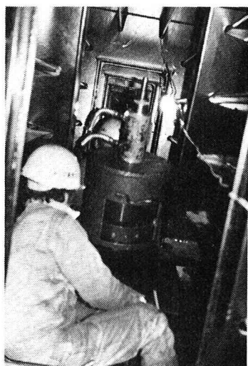
写真-2 現場の張力調整
