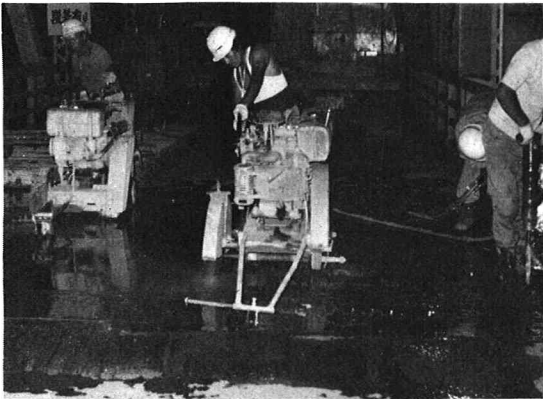
(5) 旧床版解体後プレキャスト床版布設
