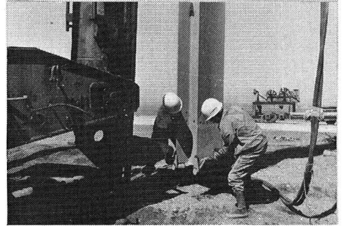
写真-1 杭打機とコンパクター
