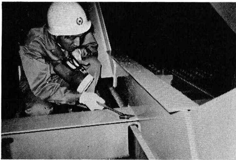
写真-4 縦トラス
