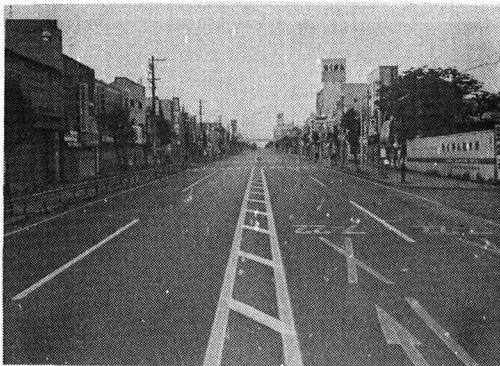
写-4 補修後の路面状況
