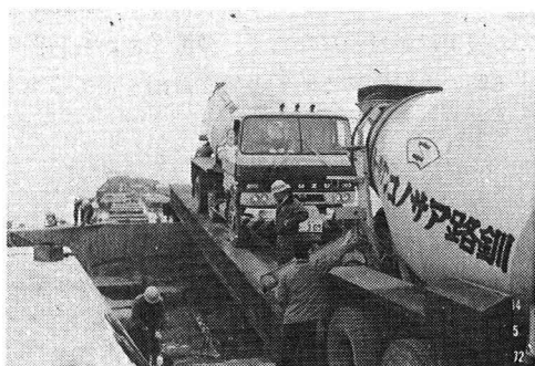
写真-2 上部コンクリート打設
