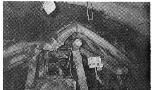
鋼管支保工上半肩部
