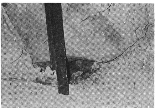
写真－７ 礮処理後切羽左側の空洞入口
