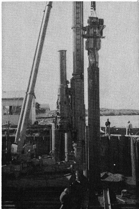
写真2 杭打機及ハンマー
