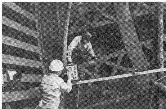
写真-2 ラジアルゲート脚部肉厚 測定状況
