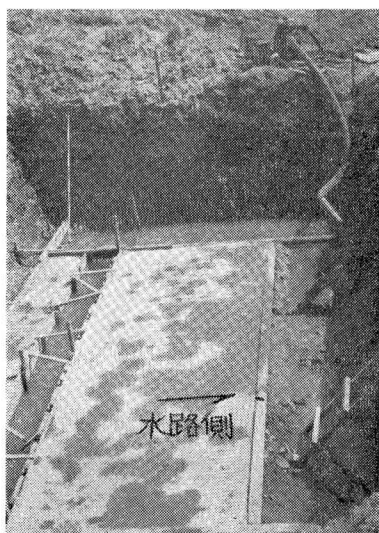
写真-3 フーチング鉄筋作前捨コン面
